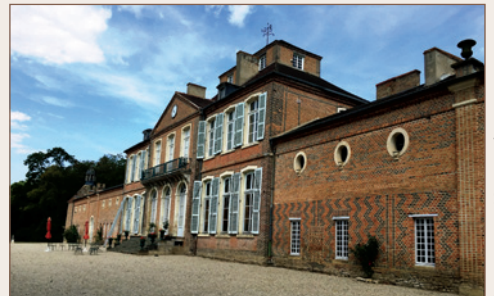
Façade du château
